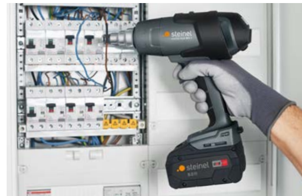
Kabel schrumpfen
